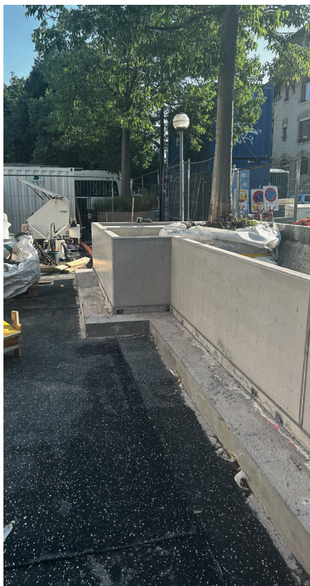
Fig. 7, 8 et 9: Muret en béton armé type 4 sur sa semelle inversée coulée sur la protection d'étanchéité de la dalle de sous-sol. On devine la présence des réservations pour le passage de l'eau sous la fondation. Les mottes des arbres, encore protégées par le matelas pédologique, sont prêtes à être remblayées avec de la terre végétale enrichie de compost. Centre: Les micocouliers retrouvent un environnement racinaire plus favorable grâce à la présence de murets de soutènement, en gneiss du côté rue pour conserver la typologie des bordures existantes, en béton côté nouveau pavillon de l'EMS. Droite: Où l'on peut admirer la qualité de finition du béton d'un muret qui remplit parfaitement sa fonction pour accueillir un «brin» de végétation et permettre de créer un lieu en contre-bas, protégé de la rue trop proche. photos: Jacquet SA, Eric Amos (centre et droite)
