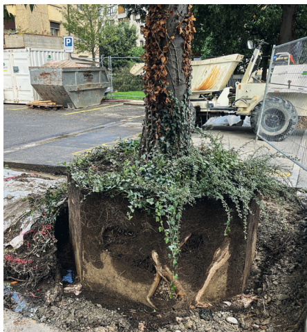
Fig. 6: Un pied de micocoulier sorti de son corset en béton avant les travaux d'aménagement du nouvel espace d'accueil de l'EMS les Pervenches. Une vision irréaliste mais explicable par la capacité d'adaptation du micocoulier, qui plonge ses racines dans la parafeuille de la dalle de sous-sol. photo: E. Amos
