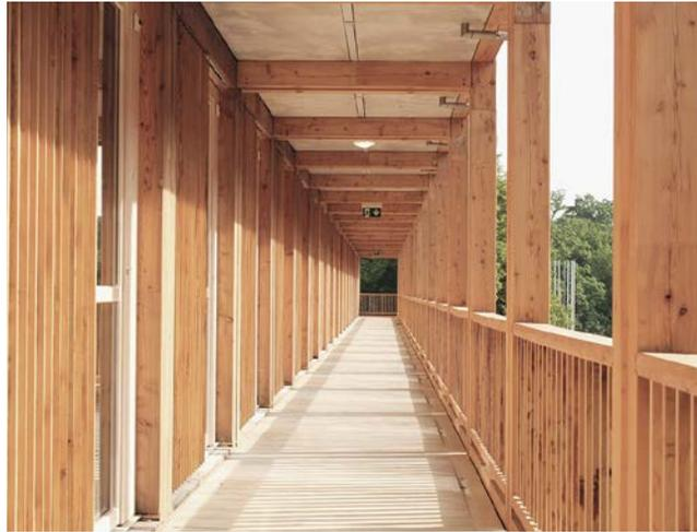
La préfabrication des modules, des salles de bains et des éléments de coursive a permis un chantier rapide sur le site.
