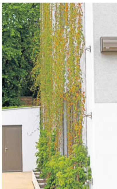
Mur vert sur façade. Réalisé avec câbles et filets en inox tendus. Ci-dessus à la crèche La Louchette, à Cognoy. Conception sur mesure adaptée aux dimensions de la façade et des ouvrants, avec ou sans filet. www.jaquet.ch . JAQUET SA
