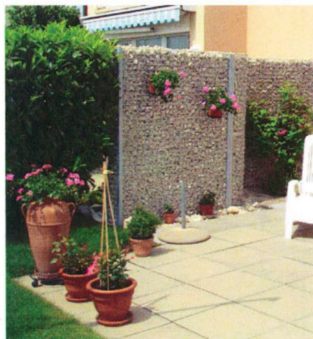
Pour séparer ces jardins contigus, on a utilisé ici des gabions en acier zingué dotés de cornières d'angle et remplis de pierre calcaire du Jura. Le maillage permet l'accrochage de plantations qui rompent l'uniformité minérale. Structure réalisée par Cribri Sàrl à Châtel-Saint-Denis, www.cribri.ch
